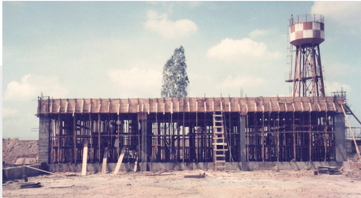
NHÀ MÁY ISUZU VIỆT NAM TRONG QUÁ TRÌNH XÂY DỰNG ISUZU VIETNAM PLANT DURING CONSTRUCTION
